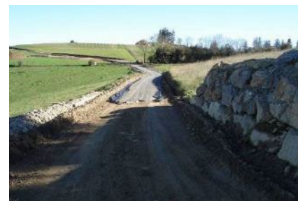
Illustration 22 : Mise en place du gravier
