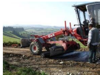
Illustration 21 : Pose du géotextile
